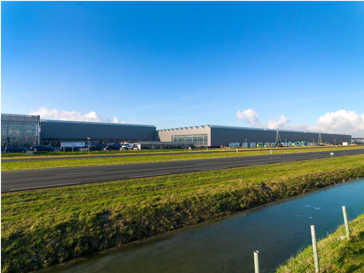
De DaglichtKas in aanbouw gezien vanaf de N211 richting Den Haag
