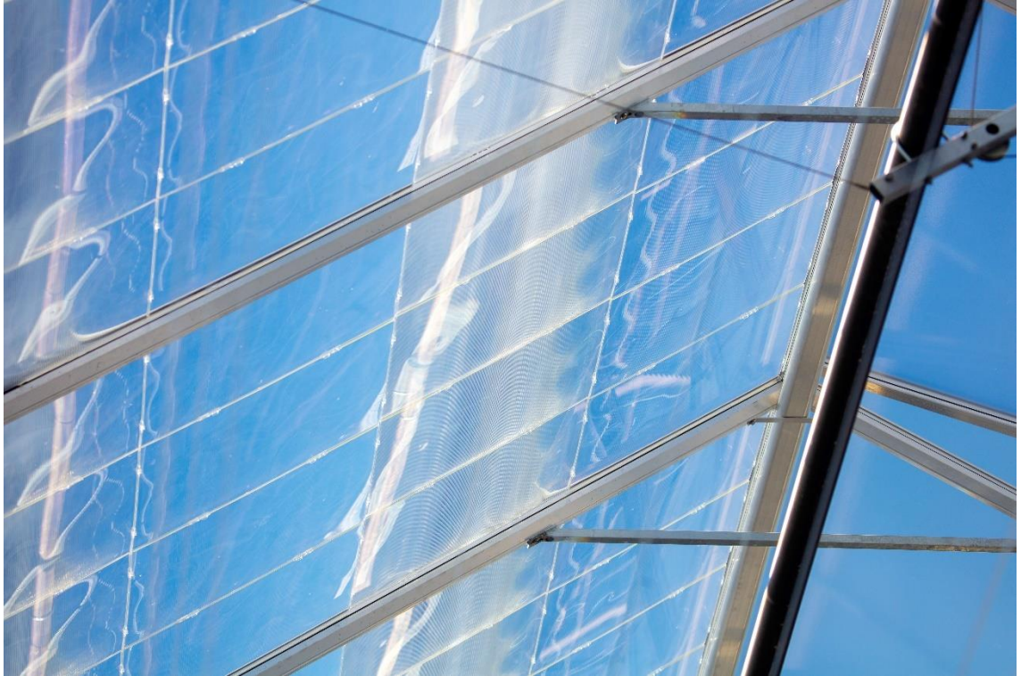
De dubbelglas panelen met daarin de PMMA lenzen
