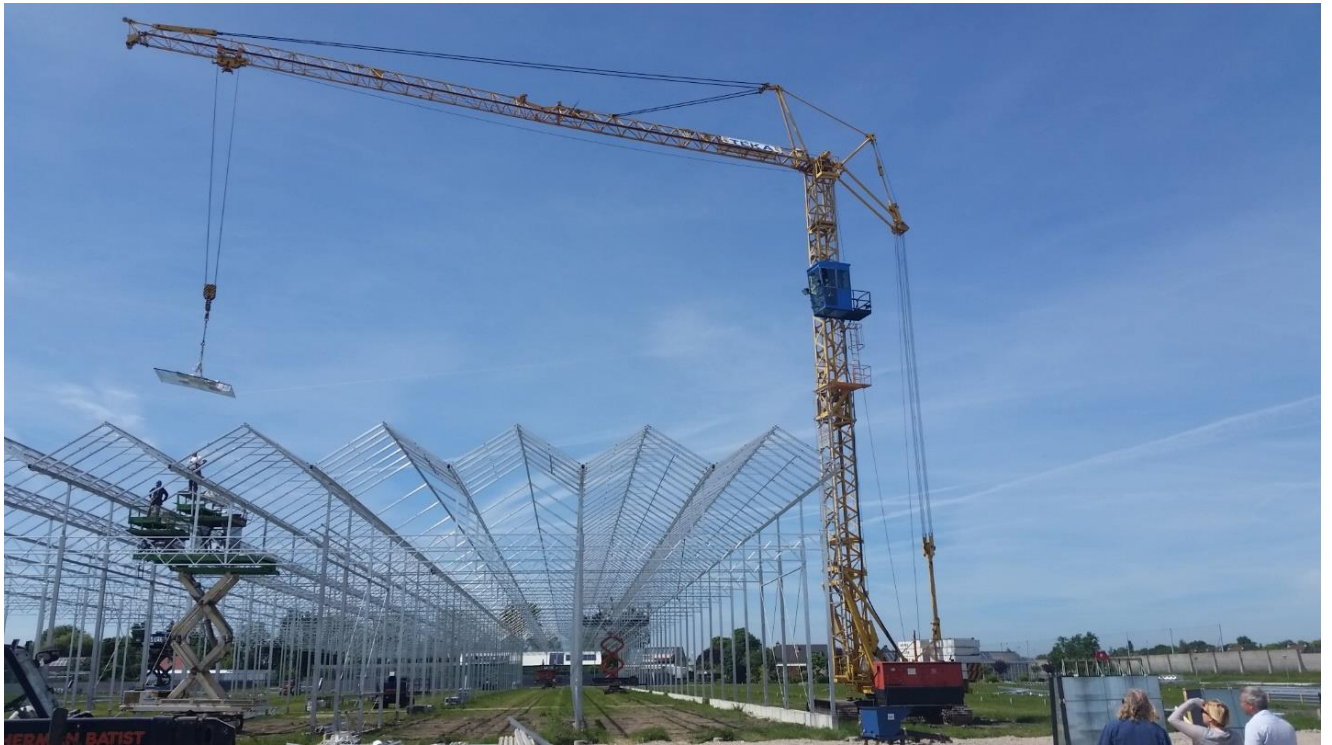
Beglazen van de dekpanelen met de kraan
