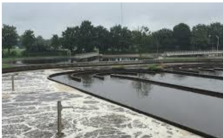
Figuur 12 - Beluchtingstank op een RWZI
