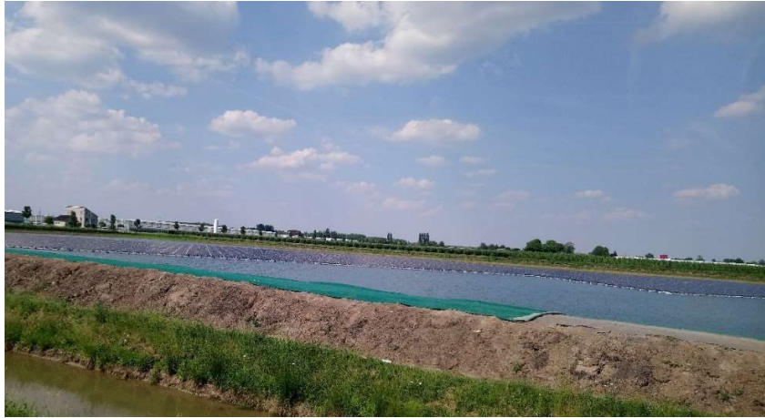
Ruim 6.000 zonnepanelen op een gietwaterbassin in Next Garden (Huissen)
