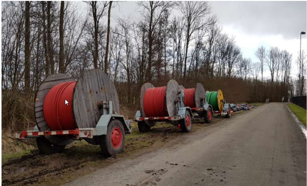
Foto: haspels met middenspanningskabels.
