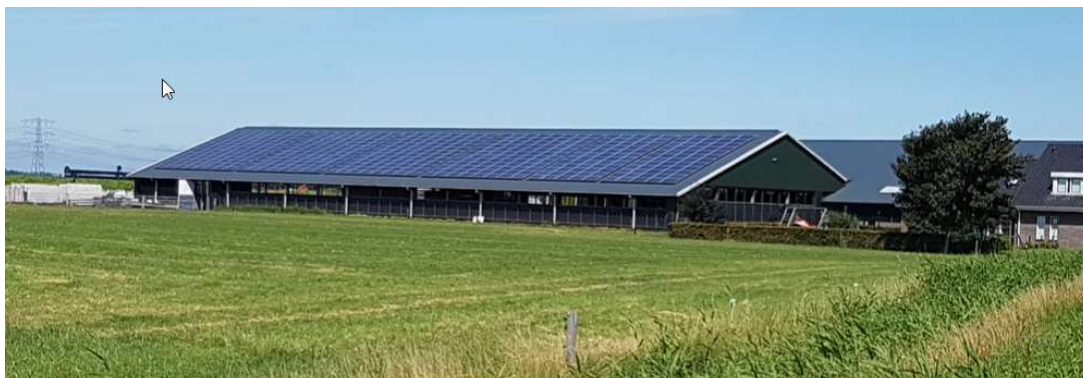
Foto: voorbeeld boerderij dak vol met PV.
