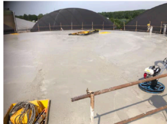
Links: Plaatsing ondersteuning voor nieuwe dak. (lining is al gemonteerd) Rechts: Nieuw betondak op hydrolyse/mengsilos
