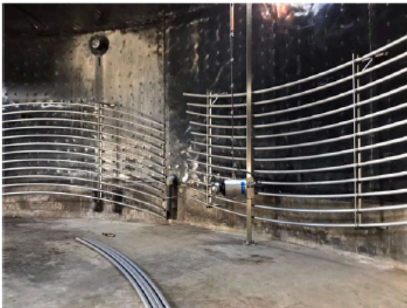
Links: Verwarmingsleidingen en nieuw roerwerk in mengtank Rechts: aanpassing warmteverdeling
