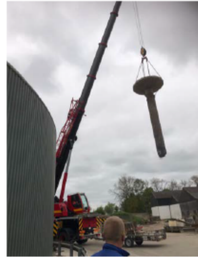
Demontage oude dak van de silo, gereed maken voor ombouw tot hydrolyse- en mengput
