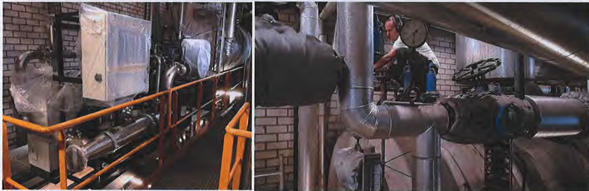
figuur 6 RCG-prototype geplaatst bij HIS en werkzaamheden aansluiting stoombuizen e.a.
