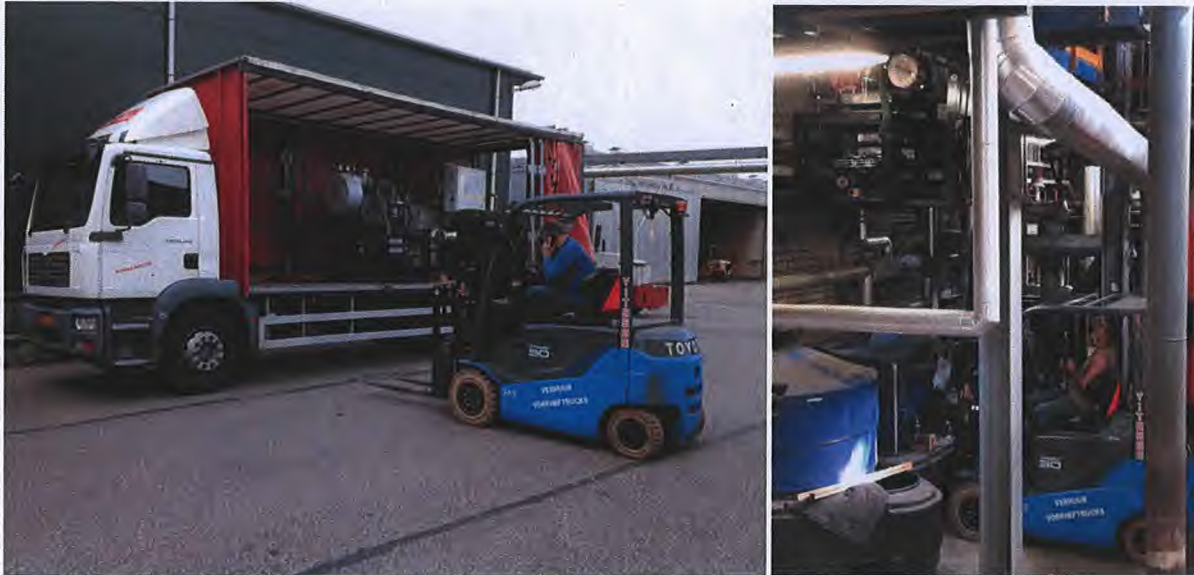
Figuur 5 transport en plaatsing RCG-prototype in ketelhuis HIS op 6m hoogte
