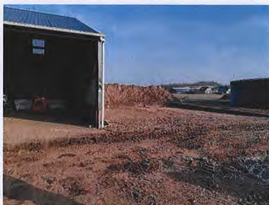
Figuur 8 Grondwerk uitbouw loods
