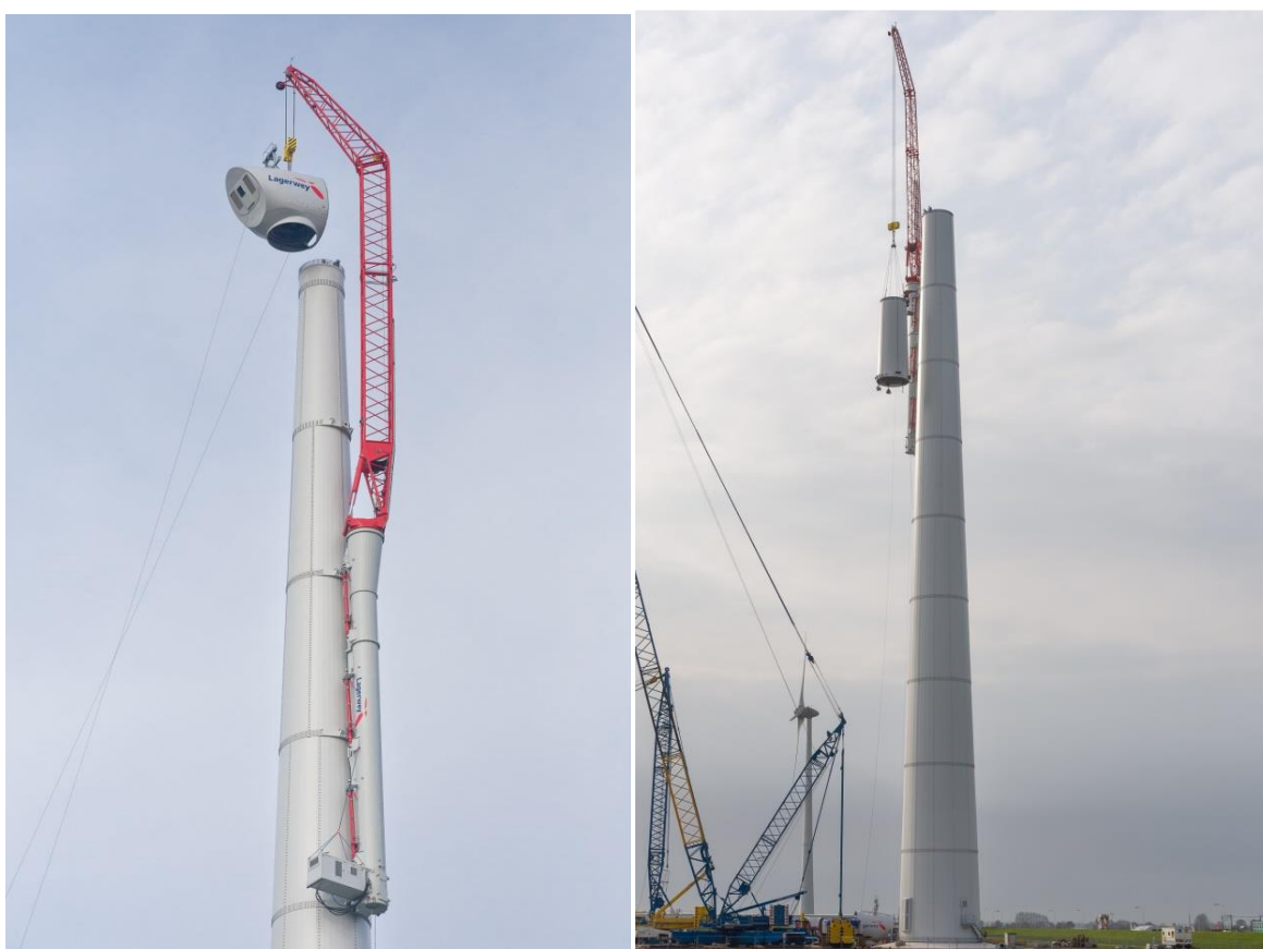
Succesvolle testen Lagerwey 'klimmende' kraan op de projectlocatie te Eemshaven
