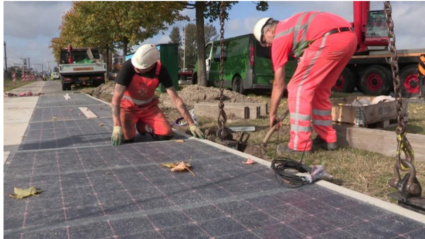
Figuur 10 Foto van element V2 tijdens plaatsing
