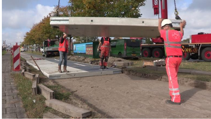
Figuur 6 Living Lab SolaRoad tijdens de aanleg
