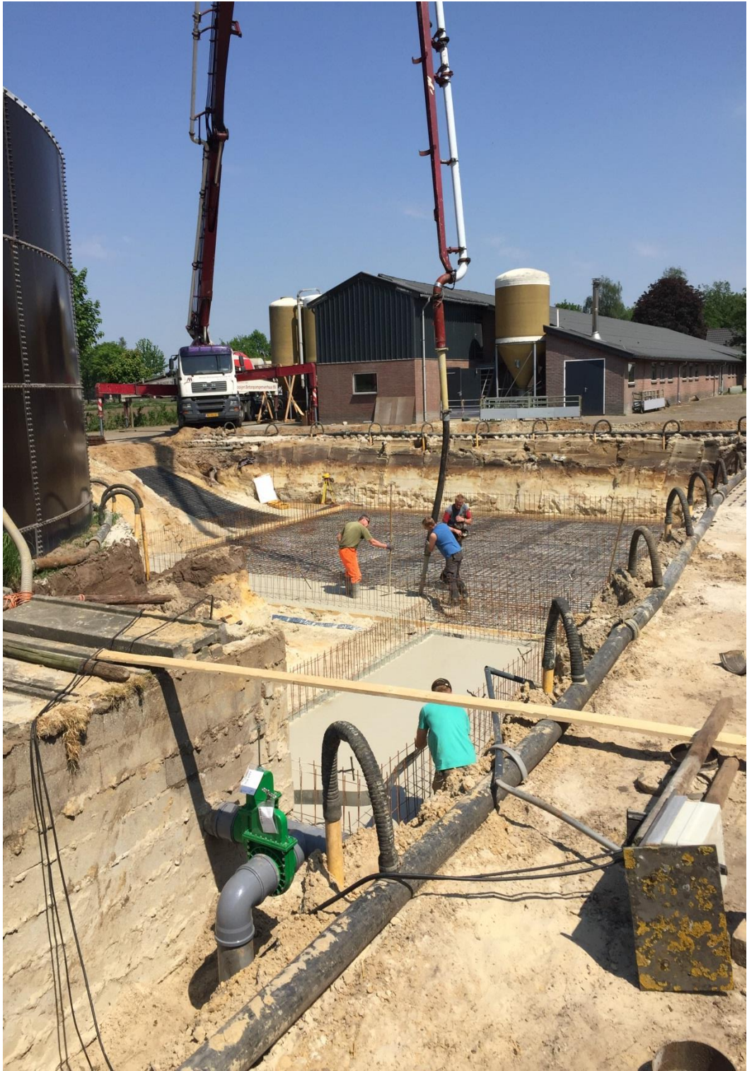
Foto: 2 Funderingen storten van de nieuwe loods
