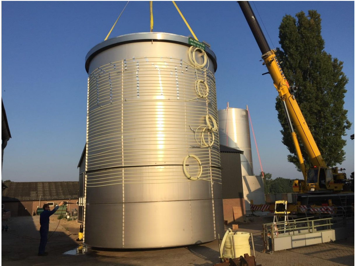
Foto 3: laatste las leggen op locatie voordat buitenste ring geplaatst wordt.
