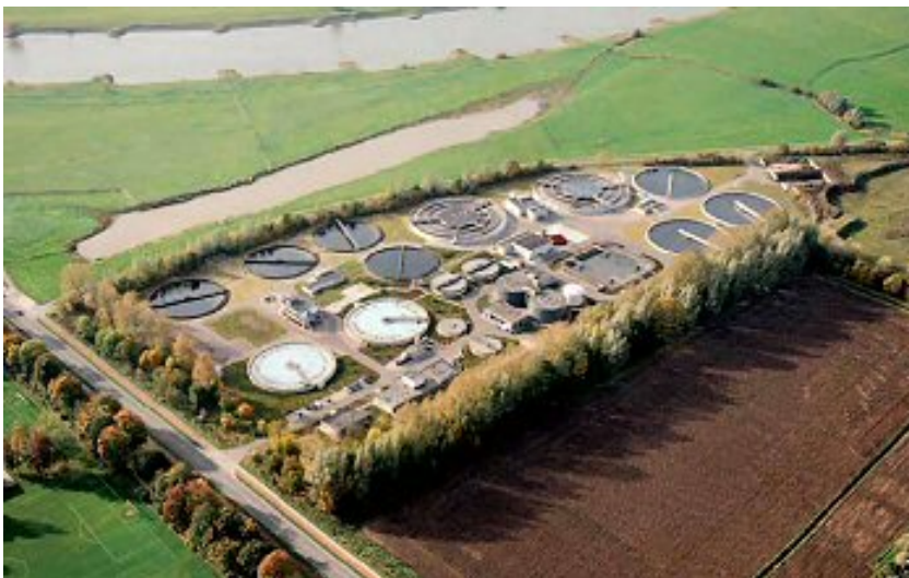
Figuur 5 Luchtfoto rwzi Deventer
