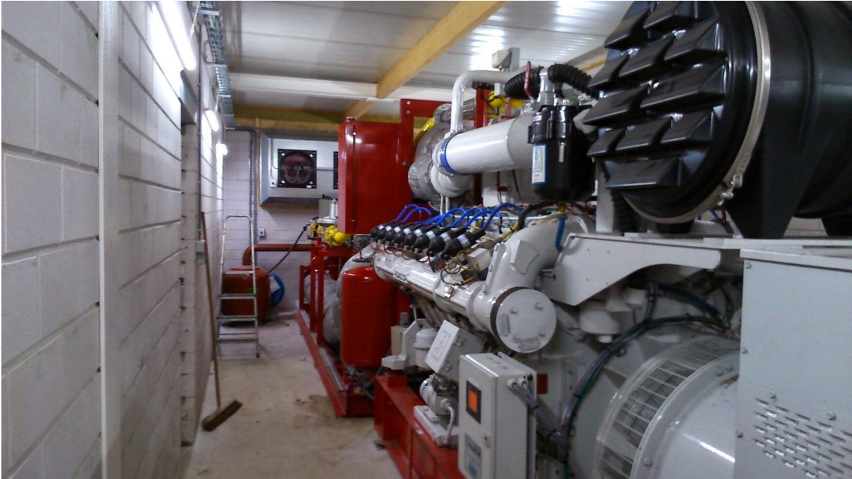
Figuur 6 Eerste WKK geplaatst
