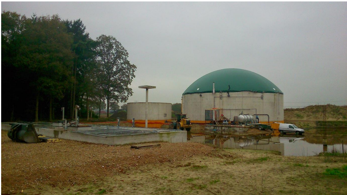
Figuur 5 De eerste vergister met in de voorgrond de mengkelder
