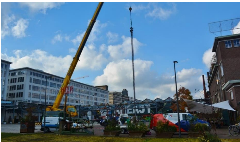
Figuur 4.5: Installatie van de meetopstelling in injectiebron I-05 op onderzoekslocatie park Strijp-S Eindhoven.
