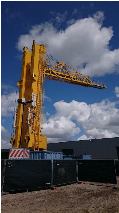
Zbridge op testlocatie Schoondijke
