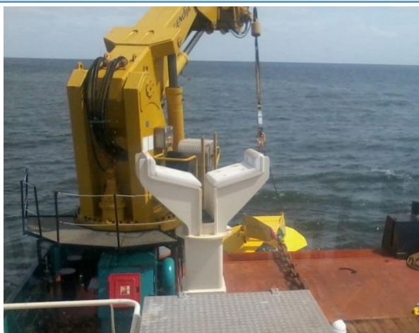
Figuur 11 installatie van de ankers in het Marsdiep
