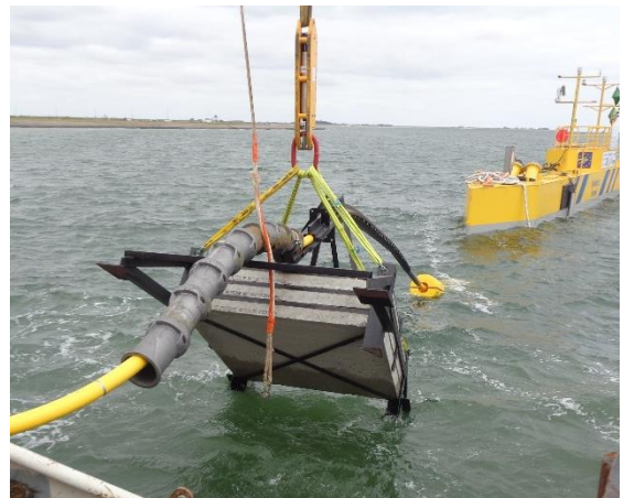
Figuur 14 installatie van het umbilical seabed frame
