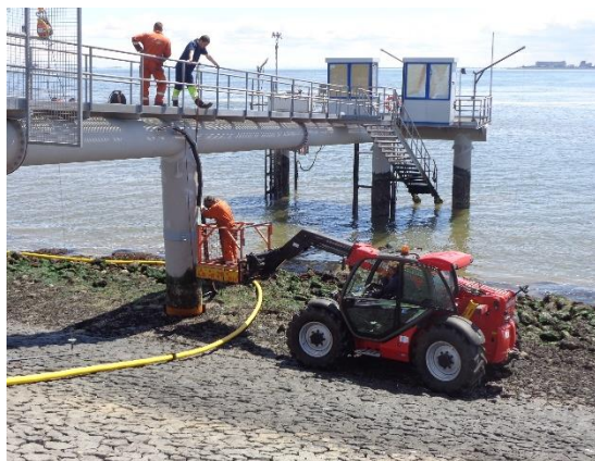
Figuur 13 Installatie van de umbilical aan de kade op Texel
