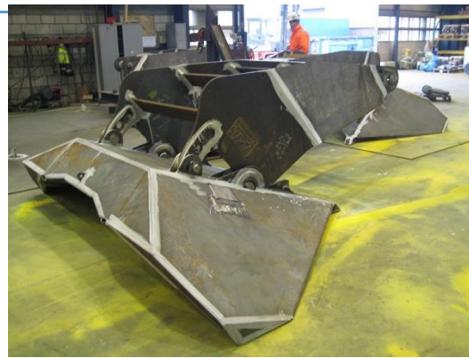
Figuur 9 Constructie van een van de ankers
