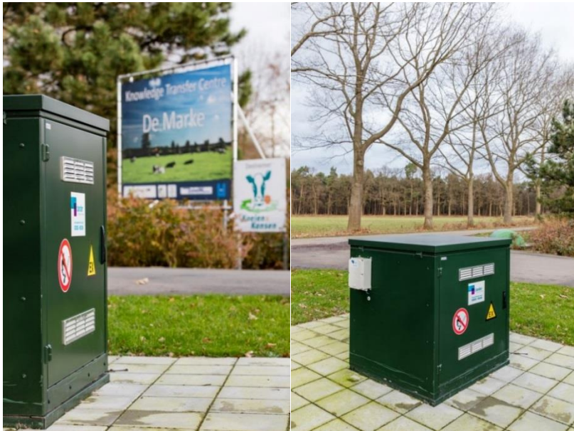
Figuur 14 Netwerk injectie punt, voor het invoeden van groen gas in het lage druk netwerk van Liander. (100 mbar(g)).
