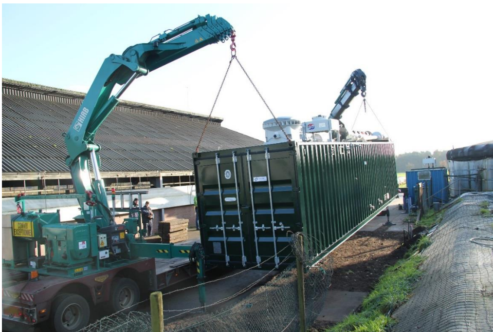
Figuur 8 Plaatsing van de container
