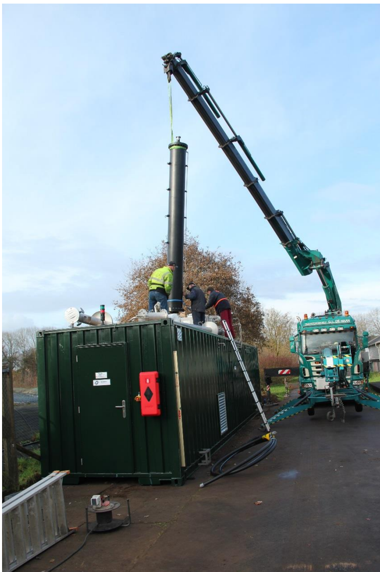
Figuur 9 Installatie van waskolom
