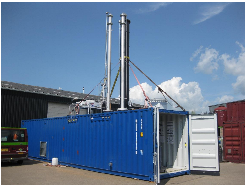
Figuur 3 Installatie in aanbouw bij Van der Wiel
