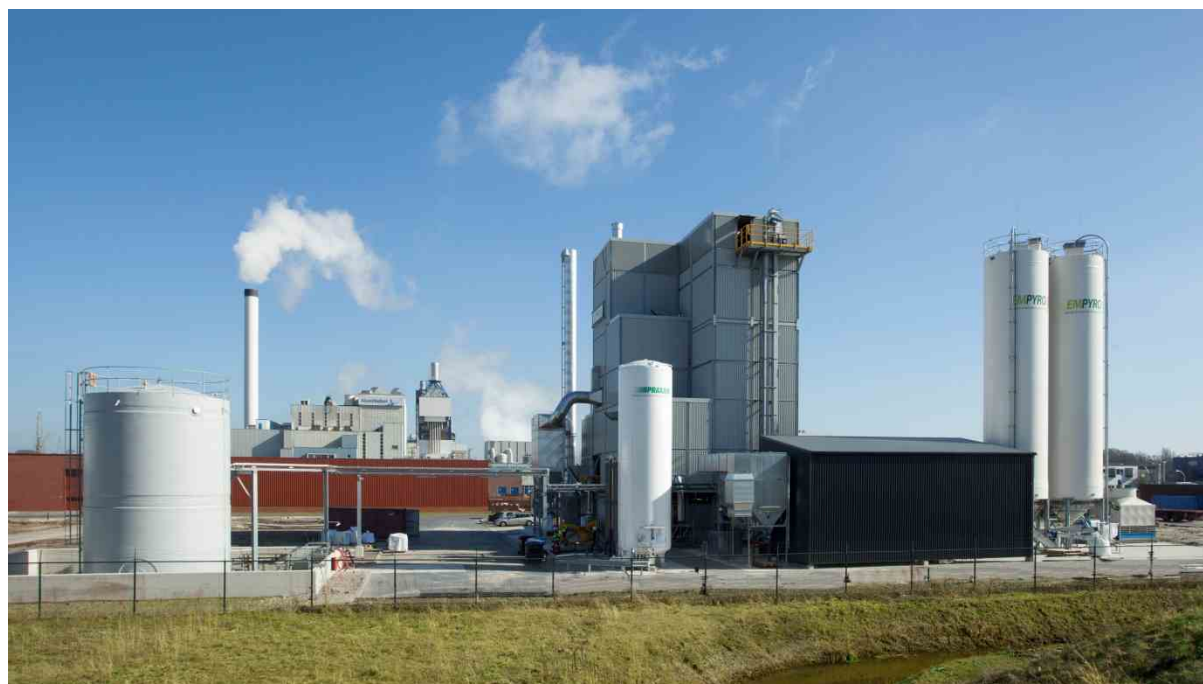
Figuur 2: De Empyro pyrolysefabriek. Hier wordt pyrolyse olie uit hout gemaakt
