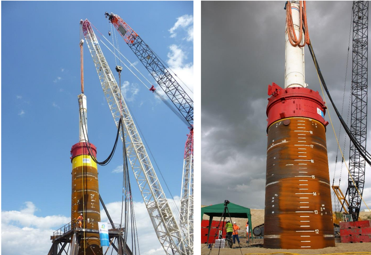
Figuur 2 - De Hydrohammer op de paal gedurende installatie. De strepen op de zijkant van de paal staan om de 25 cm.
