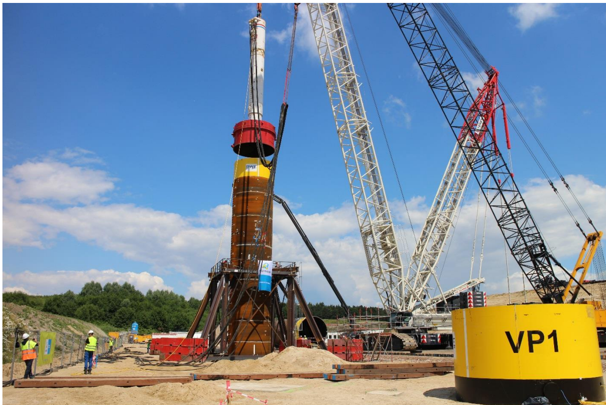
Figuur 1 - De HiLo Pile Driving installatie op de testlocatie in de Cuxhaven
