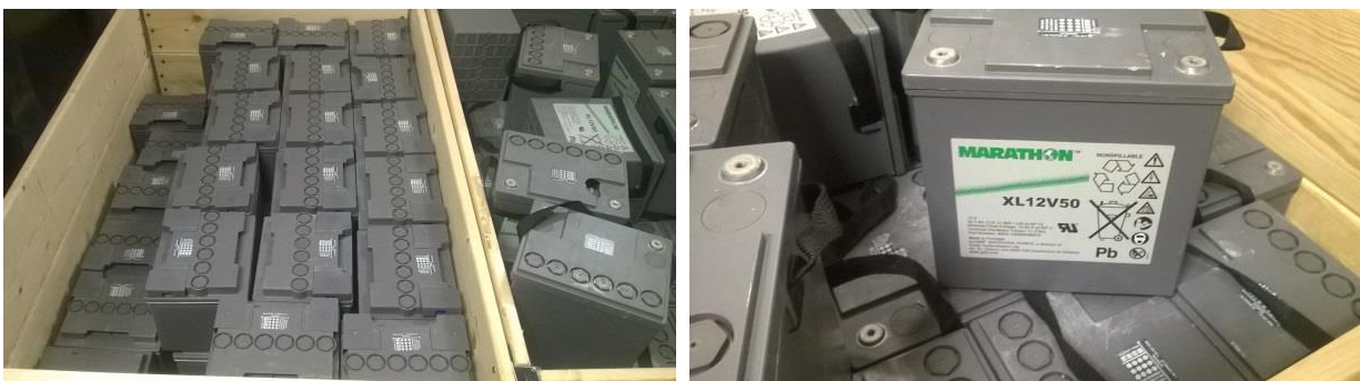
figuur 3: voorbeeld van de eerste batch ReCharge batterijen bij SUEZ Veendam
