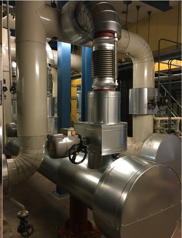
Figuur 9 Detail van de verdeler van de WKC in de nieuwe situatie. Hier is zowel de oude als de nieuwe verdeler te zien en de mengsectie van een van de takken.
