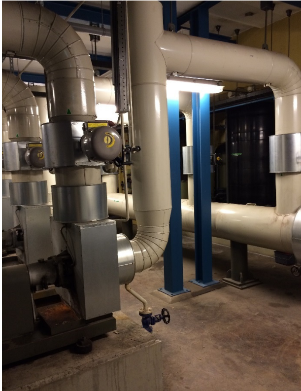
Figuur 8 Detail van de verdeler van de WKC in de oude situatie met de leiding van de verdeler naar een van de takken.
