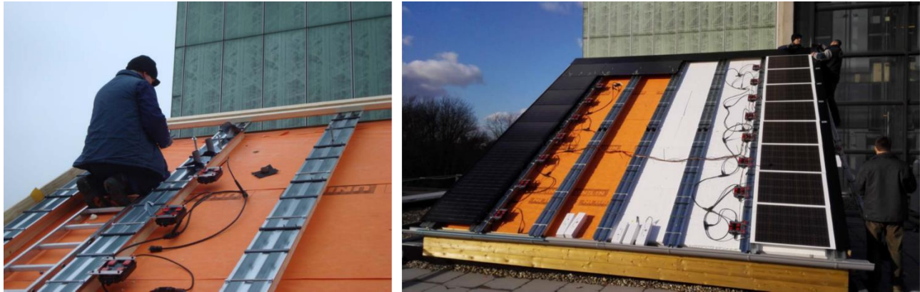
Figuur 8 Installatie van bevestigingsgoten en randafwerking op SEAC testsite
