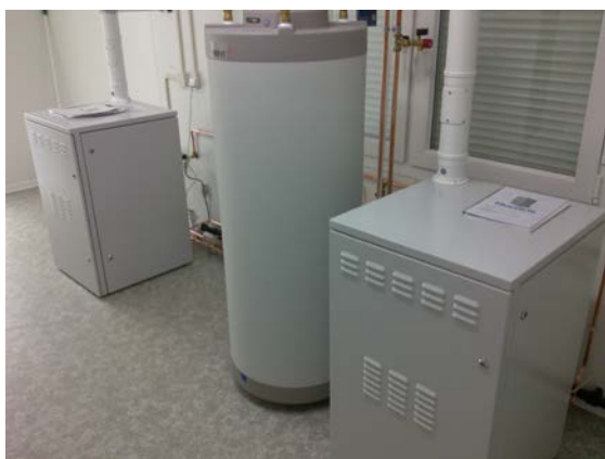
Figuur 12: opstelling van 2 Bluegens met 1 gedeeld warmtevat
