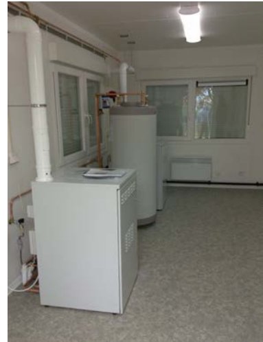
Figuur 4: inhoud van Cabine 1: 2 Bluegen's en een warmtebuffer
